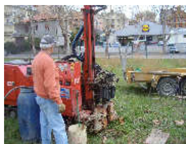
foto 3: esecuzione sond. S3
