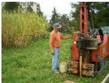
foto 1: esecuzione sond. S1
