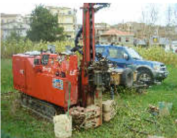
foto 2: esecuzione sond. S2
