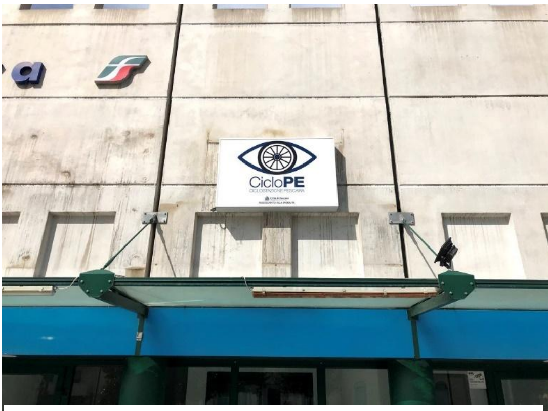
La ciclo stazione presso la stazione ferroviaria di Pescara Portanuova
