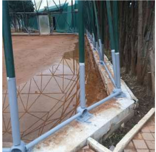
Foto n. 31-32 - Riqualificazione delle travi-cordolo di base nonché delle aste costituenti le strutture geodetiche di copertura e dei relativi nodi semisferici di vincolo alla base
