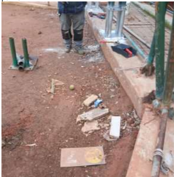
Foto n. 24 – Primi interventi riqualificativi tubolari di base delle coperture geodetiche, con sostituzione dei tubolari di base
