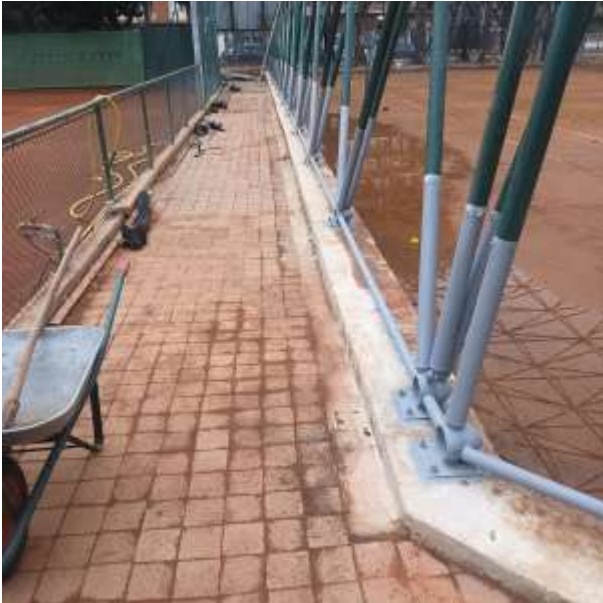
Foto n. 31-32 - Riqualificazione delle travi-cordolo di base nonché delle aste costituenti le strutture geodetiche di copertura e dei relativi nodi semisferici di vincolo alla base
