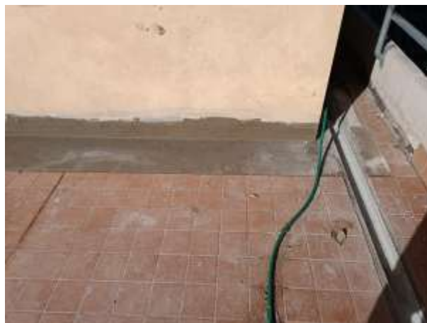
Foto n. 10 – Interventi sistema di captazione - raccolta acque di origine meteorica sulla copertura piana spogliatoi
