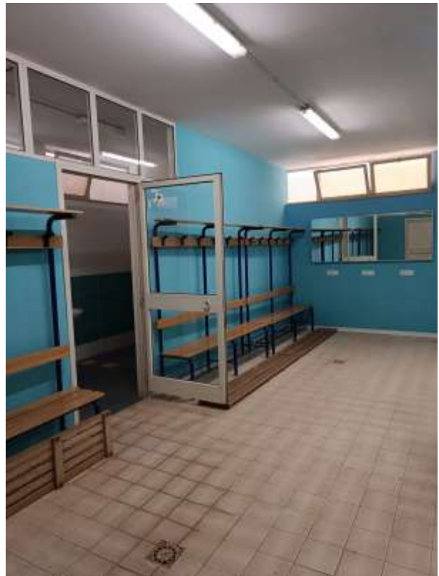
Foto n. 18 – Spogliatoio maschile a nuovi lavori ultimati 1.06.2025
