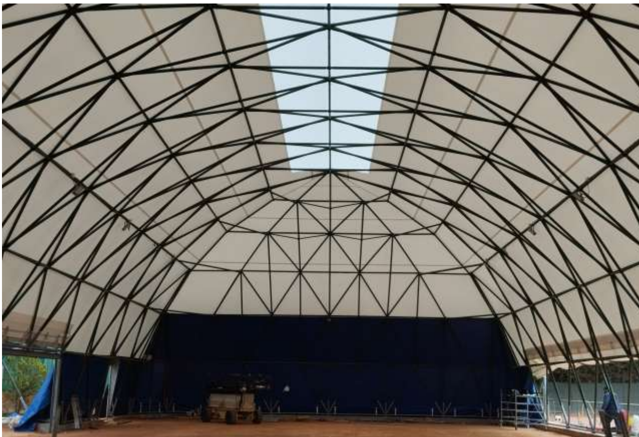
Foto n. 33 - Nuovo telo di copertura su struttura geodetica riqualificata del campo n. 6
