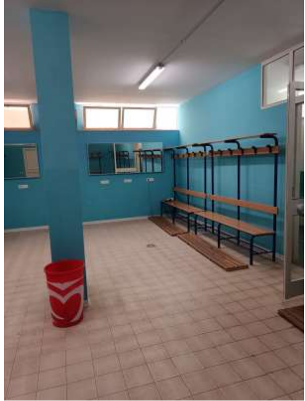
Foto n. 16 – Spogliatoio maschile a nuovi lavori ultimati 1.06.2025
