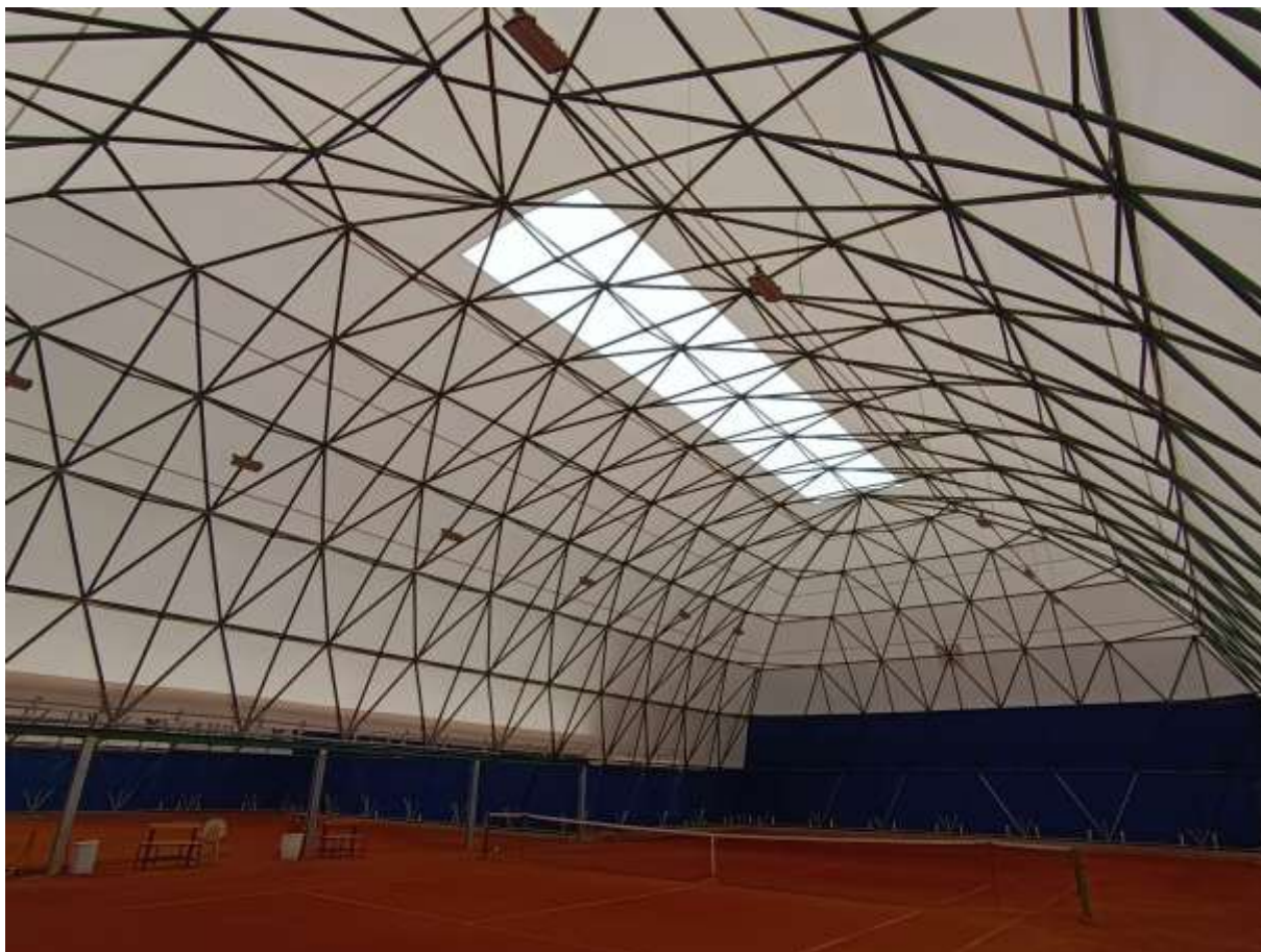
Foto n. 35 - Nuovo telo di copertura su struttura geodetica riqualificata del campo n. 7
