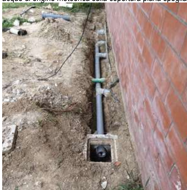
Foto n. 12 – Intervento di completa sostituzione delle linee esterne al blocco spogliatoi donne.
