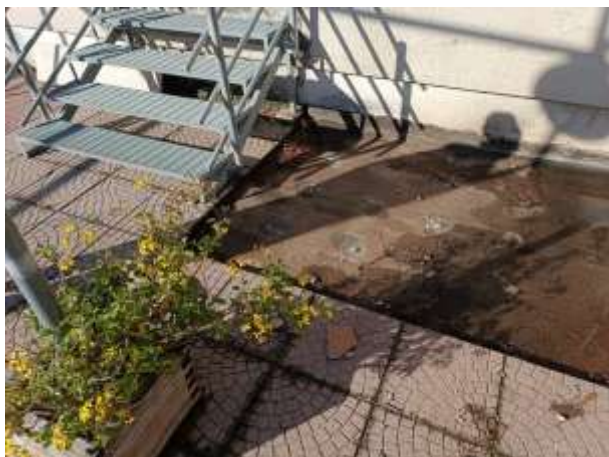
Foto n. 9 – Interventi di riqualificazione parziale impermeabilizzazione copertura piana spogliatoi
