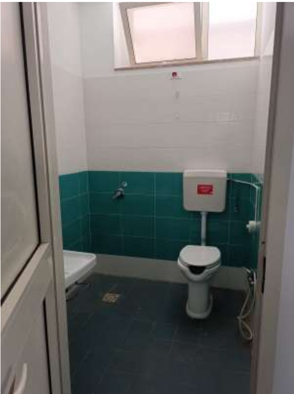
Foto n. 17 – Bagno spogliatoio maschile a nuovi lavori ultimati 1.06.2025
