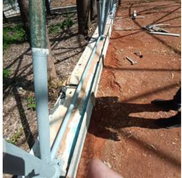
Foto n. 29-30 - Riqualificazione delle travi-cordolo di base nonché delle aste costituenti le strutture geodetiche di copertura e dei relativi nodi semisferici di vincolo alla base
