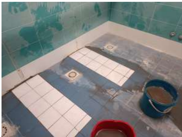
Foto n. 4 - Sigillatura pilozze scarico e ripristino pavimentazione zone docce
