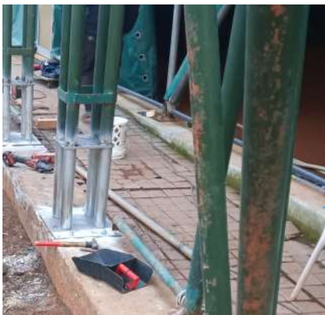
Foto n. 27-28 - Riqualificazione delle colonne calastrellate preesistenti con sostituzione delle basi con nuovi, con ripristino continuità con saldature a completa
