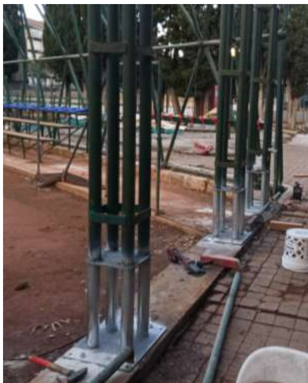
Foto n. 27-28 - Riqualificazione delle colonne calastrellate preesistenti con sostituzione delle basi con nuovi, con ripristino continuità con saldature a completa
