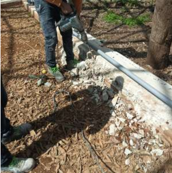
Foto n. 29-30 - Riqualificazione delle travi-cordolo di base nonché delle aste costituenti le strutture geodetiche di copertura e dei relativi nodi semisferici di vincolo alla base
