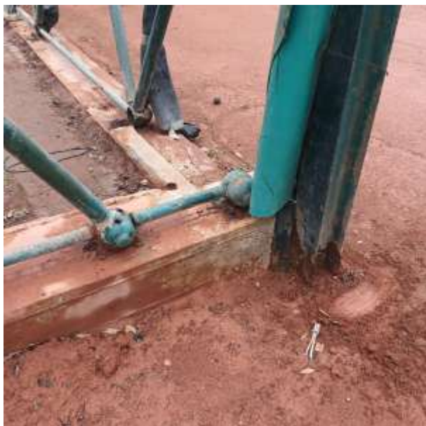
Foto n. 23 – Situazione colonna metallica d'angolo comune alle coperture geodetiche dei campi n. 6 e 7, a seguito lavori di pulizia
