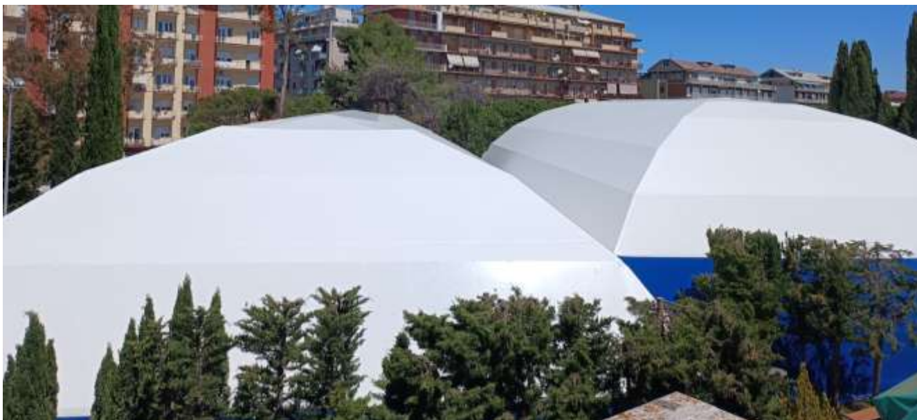
Foto n. 37 - Nuovi teli di copertura su strutture geodetiche riqualficate dei campi n. 6 e 7
