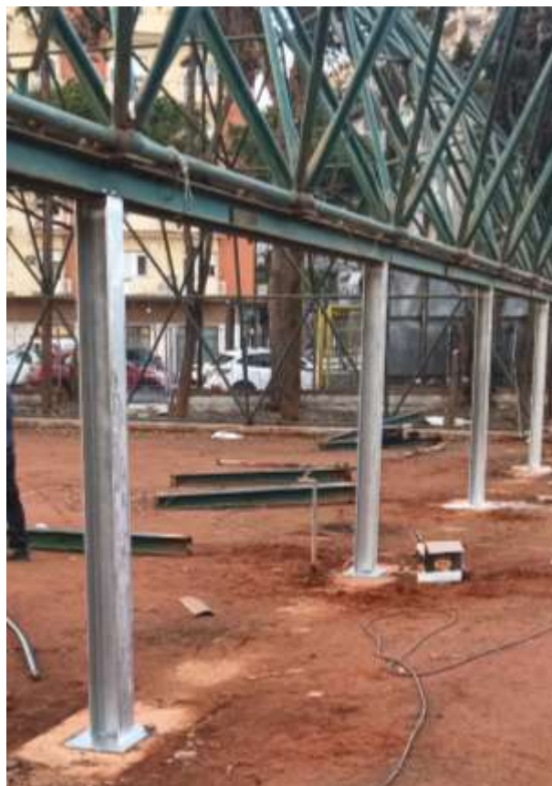
Foto n. 26 – Primi interventi indifferibili ed urgenti di sostituzione colonne metalliche comuni alle coperture geodetiche dei campi n. 6 e 7, con nuovi in acciaio zincato a caldo
