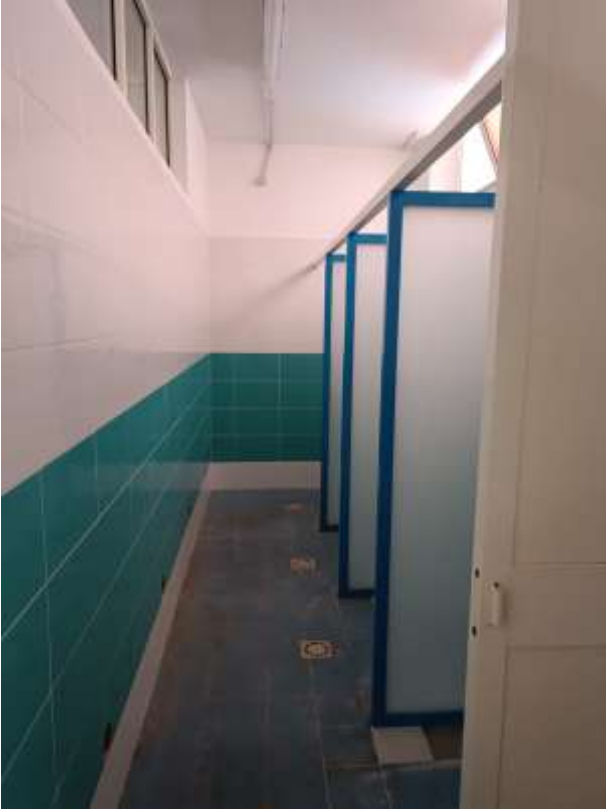
Foto n. 15 – Docce spogliatoio maschile a nuovi lavori ultimati 1.06.2025
