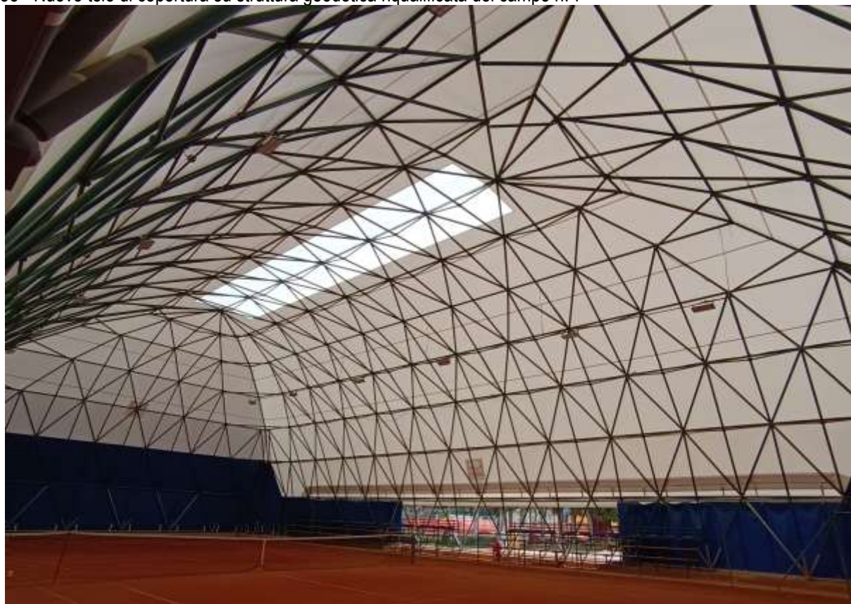
Foto n. 36 - Nuovo telo di copertura su struttura geodetica riqualificata del campo n. 7
