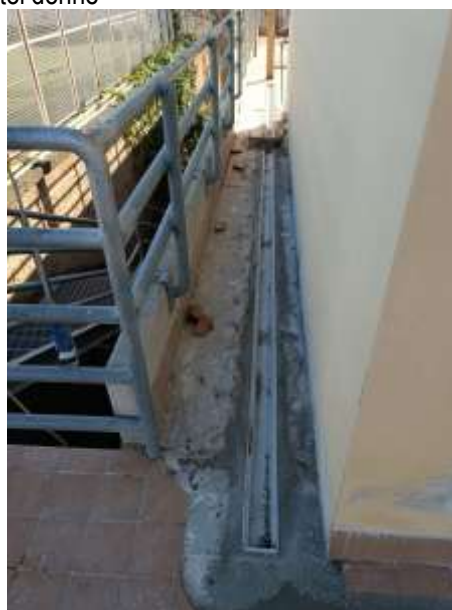
Foto n. 8 - Interventi sistema di captazione - raccolta acque di origine meteorica sulla copertura piana spogliatoi
