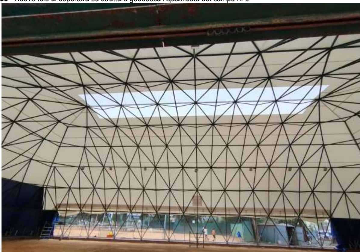
Foto n. 34 - Nuovo telo di copertura su struttura geodetica riqualificata del campo n. 6
