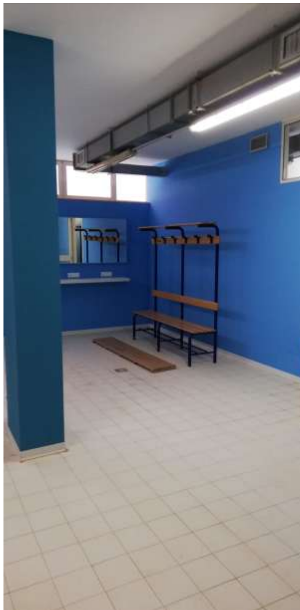
Foto n. 2 - Spogliatoio maschile a lavori ultimati 13.10.2021
