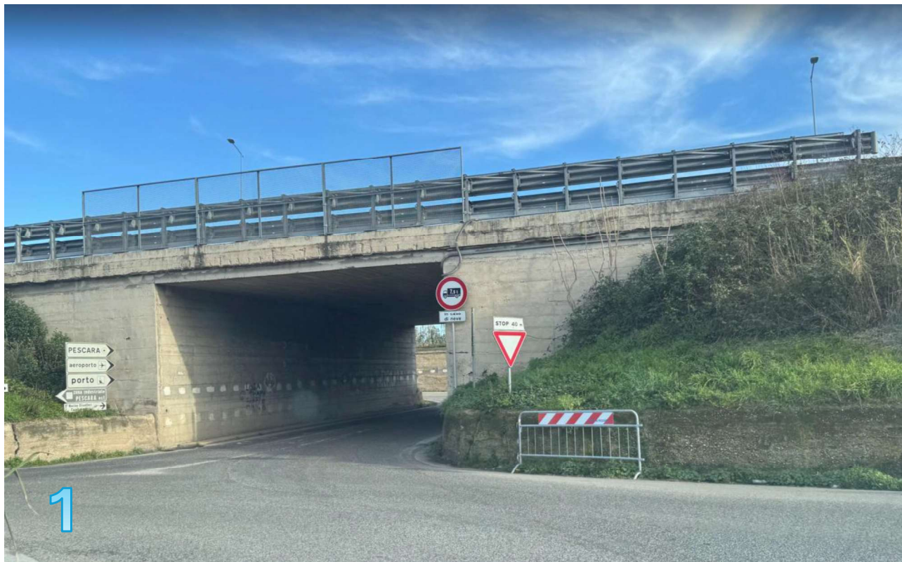
Figura 5-3: Sottopasso di via Raiale per l'accesso sull'asse attrezzato (Raccordo Autostradale Pescara-Chieti).
