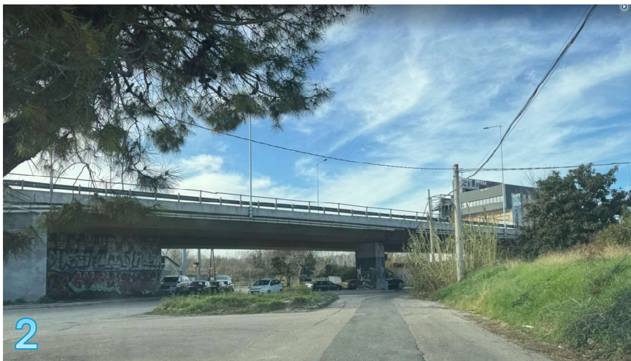
Figura 5-4: Sottopasso di via Raiale all'asse attrezzato (Raccordo Autostradale Pescara-Chieti).
