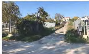
8. Ponte Argine Sud
