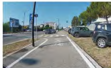
4. Attraversamenti Via A. Volta
