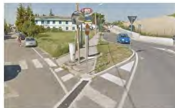
1. Intersezione Via Tirino - Strada delle Casette
