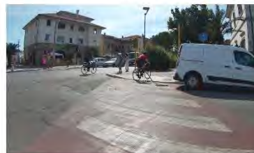
7. Attraversamento da migliorare con la realizzazione di golfi e rialzi
