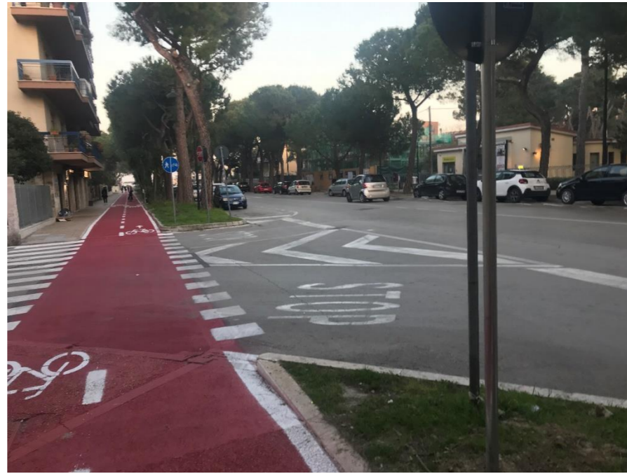
Attraversamento con doppia attestazione delle macchine
