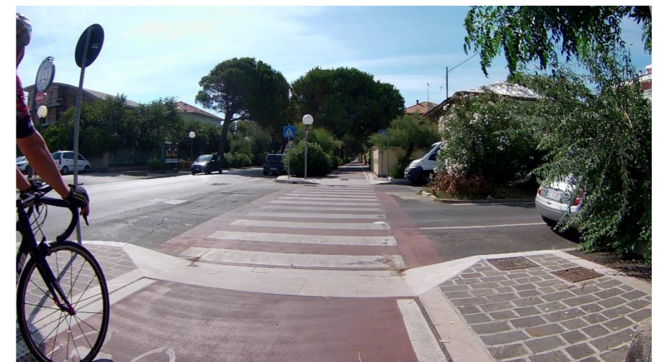
Attraversamento ciclabile e pedonale lungomare Sud non in sicurezza
