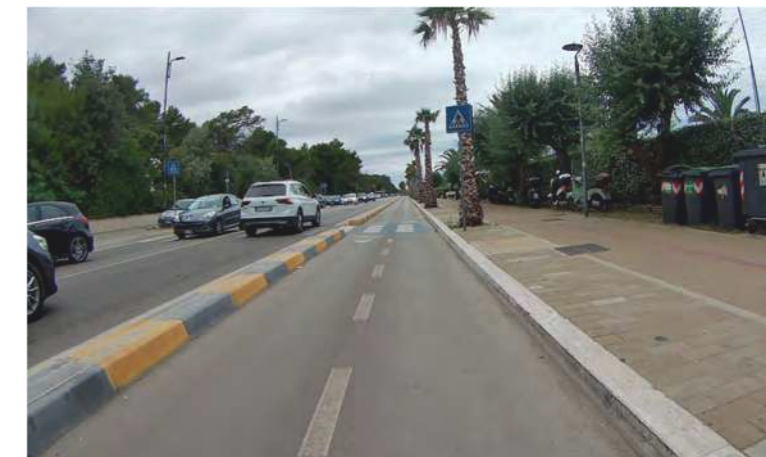
1. Pista proveniente da Montesilvano
