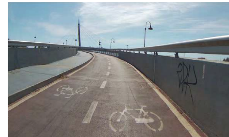
1. Ponte del Mare
