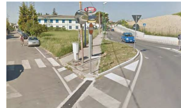
1. Intersezione Via Tirino - Strada delle Casette
